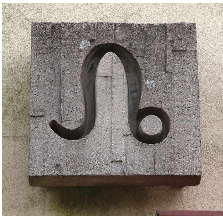
27. Detail panelu znamení lva na fasádě gymnázia v Havířově, foto: Tereza Bílková, 1. 3. 2024.
