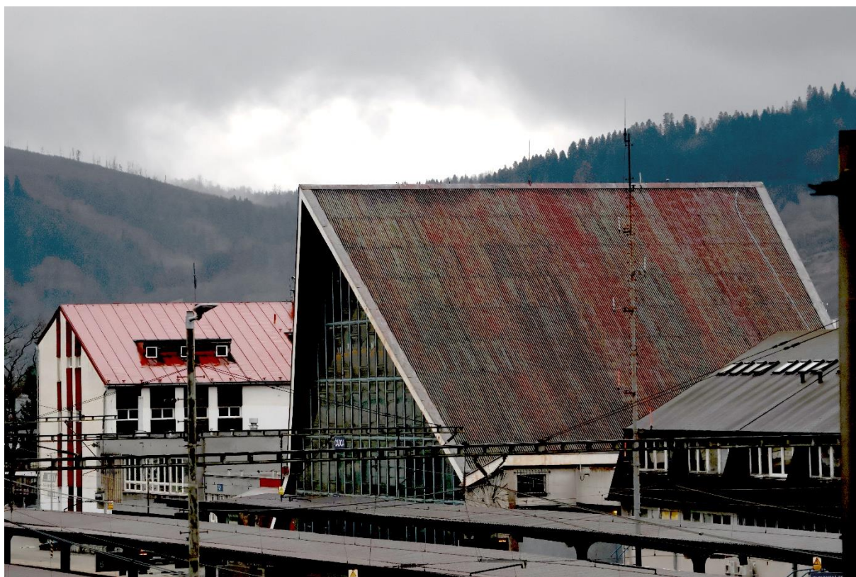
7. Výpravní hala železničního nádraží Čadca, pohled ze severu, foto: Tereza Bílková, 25. 2. 2024.
