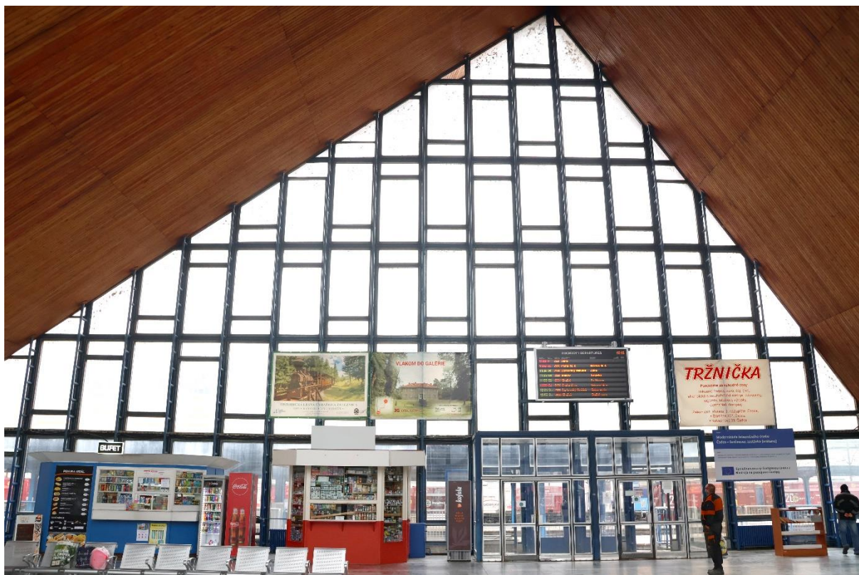
14. Severovýchodní fasáda nádražní haly v Čadci, focena z interiéru společně s rušivými prvky, foto: Tereza Bílková, 25. 2. 2024.
