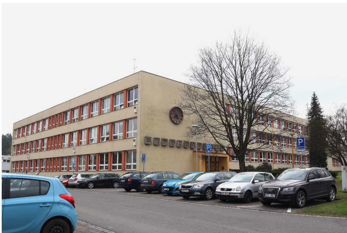
18. Gymnázium na ulici Studentská v Havířově, pohled ze severozápadu, foto: Tereza Bílková, 1. 3. 2024.
